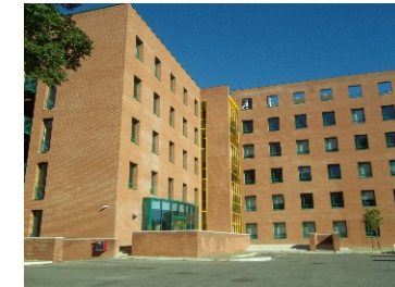
PALAZZO DIPARTIMENTI BIOLOGICI
