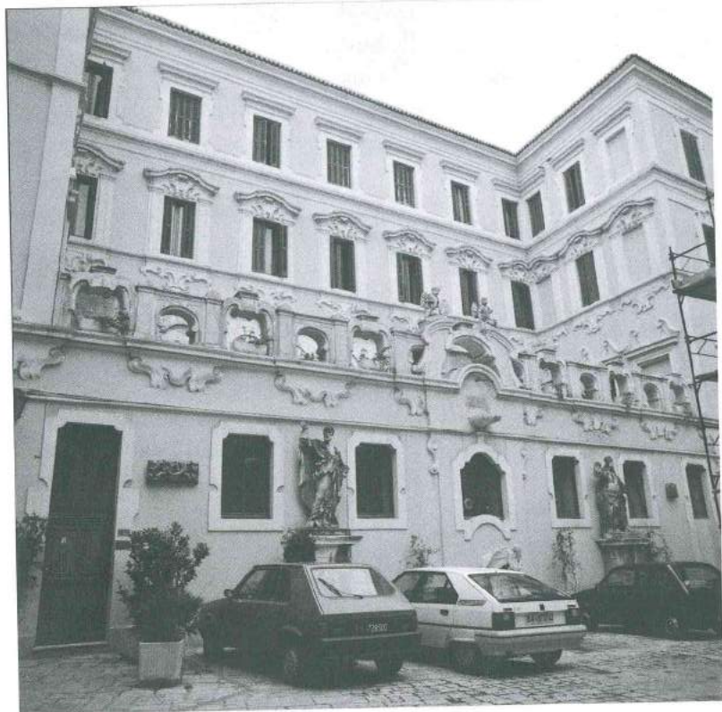
Fig. 2. Bari. Palazzo del Seminario. D.A. Vaccaro, decorazione a stucco del prospetto.
