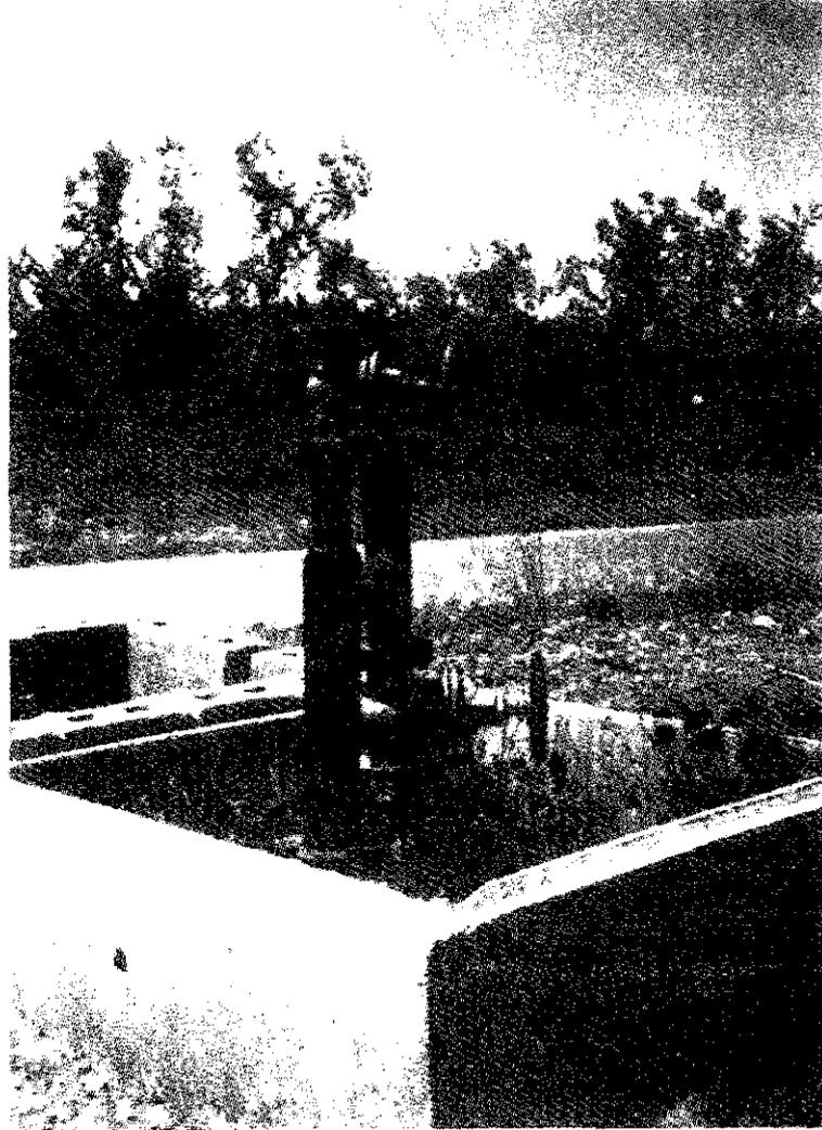
Fig. VI-34 - Idrante con presa e saracinesche in un impianto collettivo
